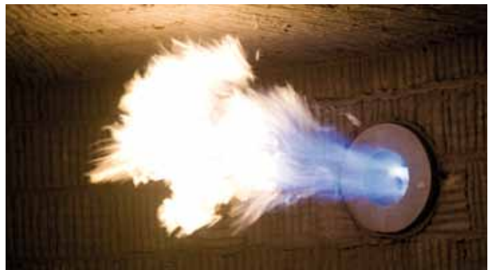
Flammenbild während der Aufheizphase. Nach Erreichen der Betriebstemperatur > 850°C werden die Brenner flammenlos betrieben. Фото пламени в фазе обогрева. После достижения рабочей температуры ок. 850 °C горелки эксплуатируются беспламеном режиме
